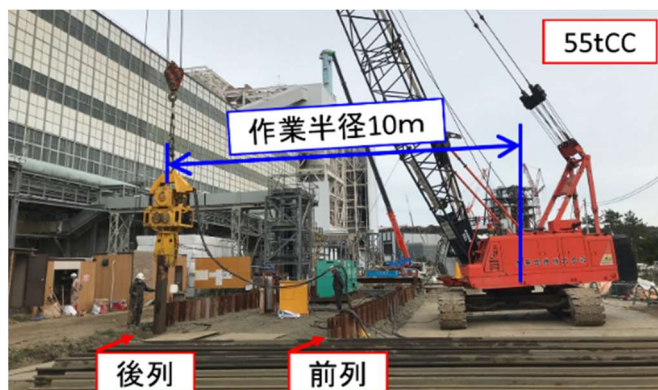
写真-1 鋼矢板引抜施工状況
