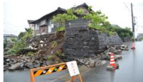
写真-1 熊本地震による被害 1)
