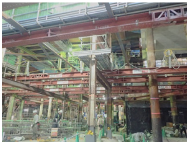
写真1 施工状況写真
