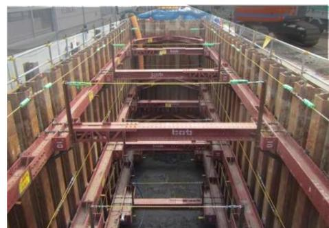
写真1. ハンマーストラット計測状況
