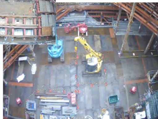
写真2 作業構台上施工状況
