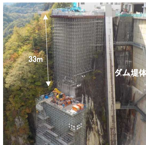
写真 1 作業構台全景
