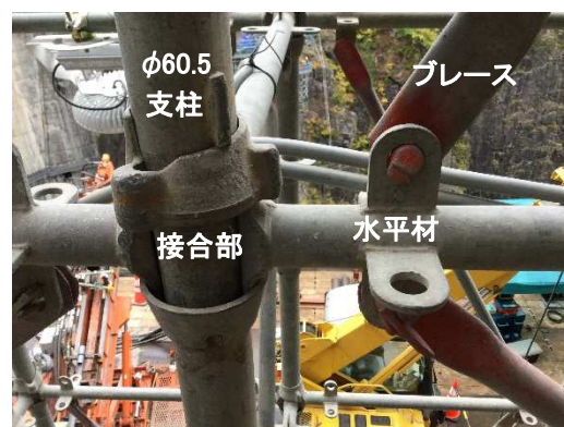
写真 2 くさび緊結式支保工
