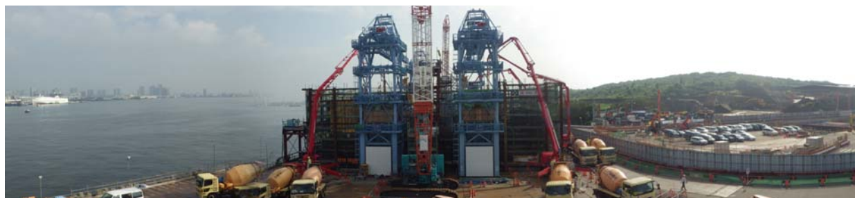
写真-1 ニューマチックケーソンの施工状況
