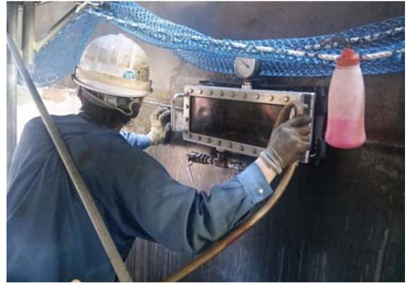
写真-4 真空箱検査(現場溶接部)
