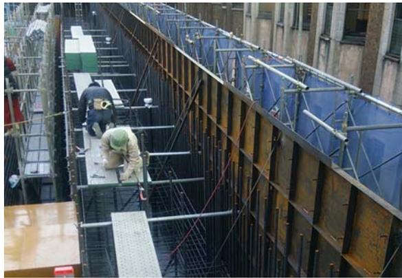
写真-3 ケーソン外周の止水鋼板
