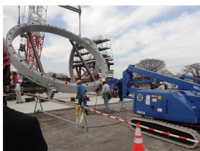
写真-2 クレーンによる立起し
