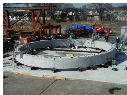
写真-1 地組状況
