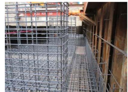
写真-5 低層棟スラブ・壁の配筋
