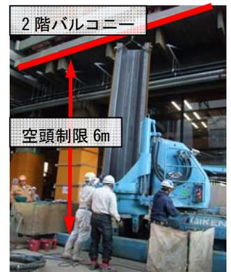
写真-3 空頭制限箇所施工
