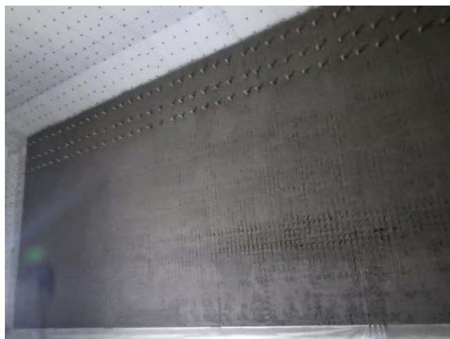
図-4. 耐火吹付工 1層目施工完了
