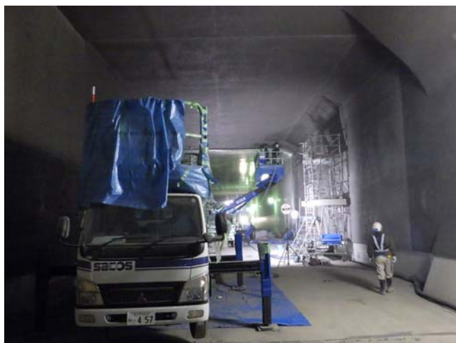
図-3. 耐火吹付工作業状況
