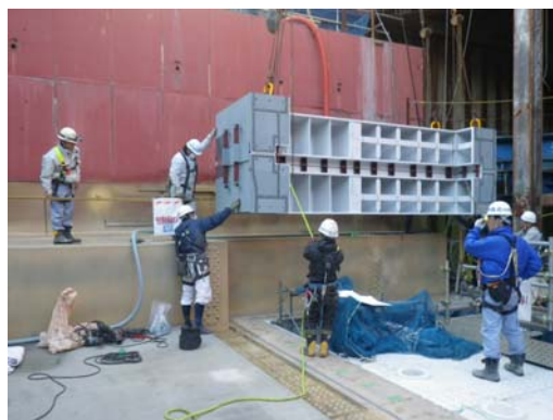
図-5. 階段立坑架設状況
