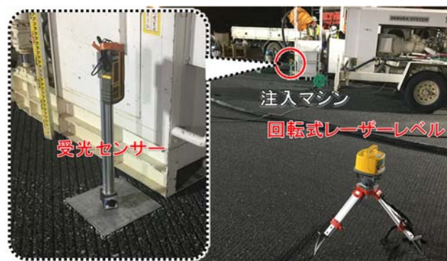
図-2 レーザー測量による隆起監視状況
