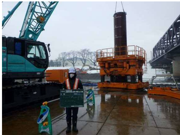
写真-1 足羽川内ケーシング建込状況
