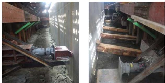
写真-2 ケーソンの傾斜防止対策
