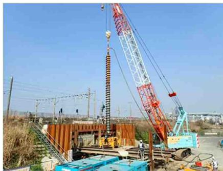
図 7 ダウンザホールハンマー 施工状況
