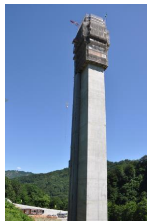
写真-1 80m超高橋脚施工状況 (国道289号5号橋梁下部工その2工事)
