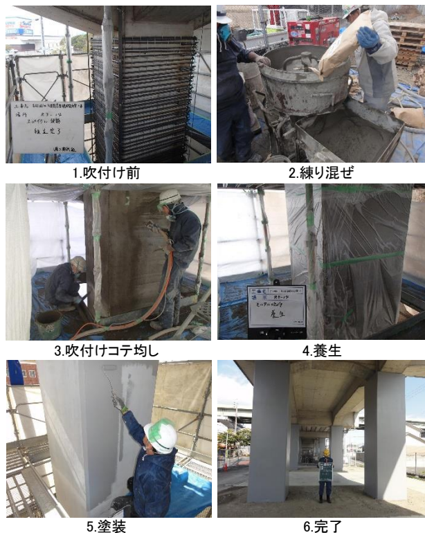
写真-2 施工状況
