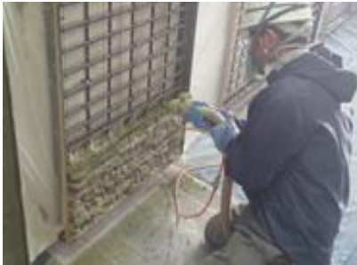
写真-1 吹付け状況
