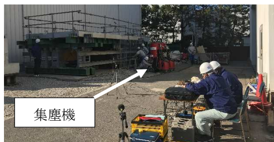
写真-3：乾式ワイヤーソーによる切断状況
