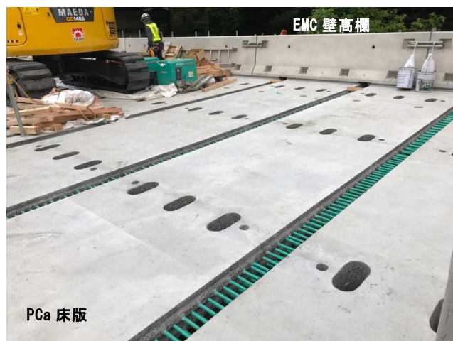
写真-2 施工状況 (PCa 床版・EMC 壁高欄架設直後)
