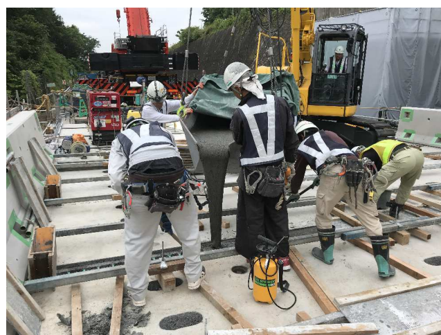
写真-3 スリムクリート打設状況
