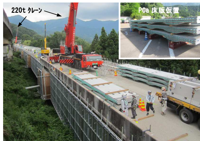
写真-1 PCa 床版の仮置・架設状況
