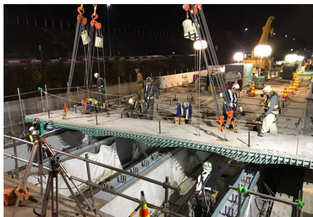
写真-1 PCa 床版 架設状況
