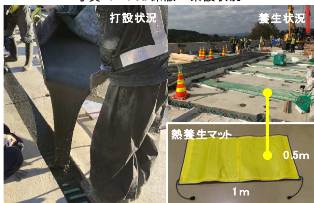
写真-2 床版接合部施工状況（左）・養生状況（右）
