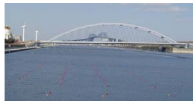
図_5.1 工事状況写真
