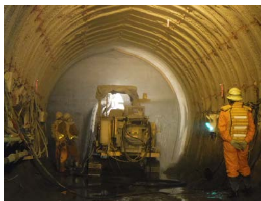
写真-1 吹付け状況
