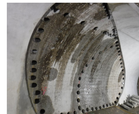
写真-3 コア削孔によるミシン目施工
