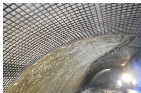
写真-1 FRP グリッド設置状況
