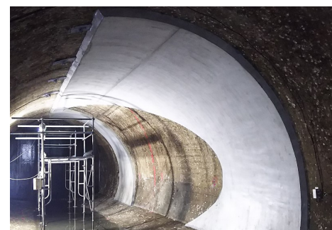
写真-2 FRP グリッド補強完了状況
