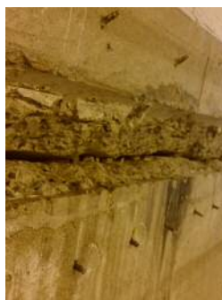
写真-2 図-4 打継ぎ目（せめ部）
