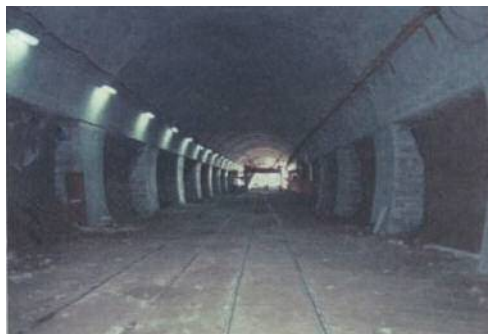
写真-1 足付け部の側壁コンクリート
