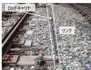
図5 リンクの構造
