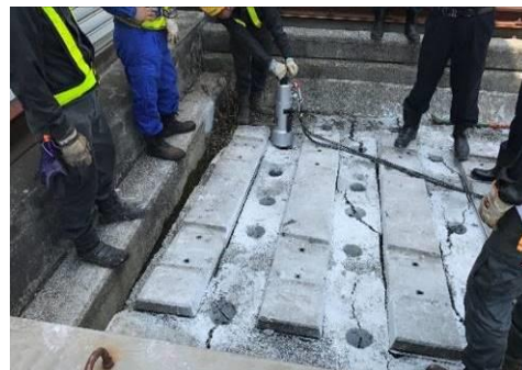
写真-2.1 スプリッター工法試験状況
