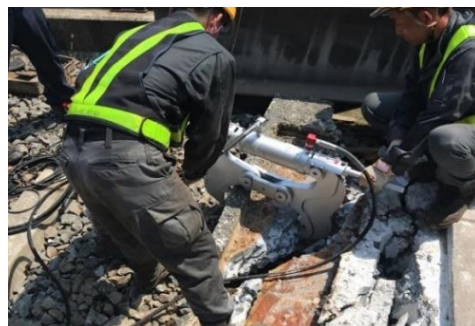
写真-2.2 二次破碎試験状況
