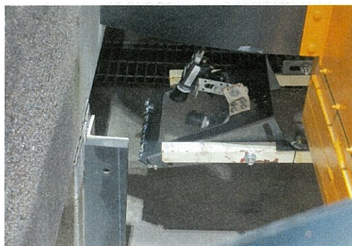
写真-1 鏡を用いた軌道桁底面の撮影
