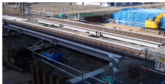
写真-1 鉄道用工事桁
