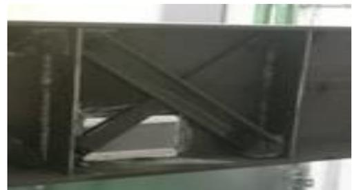
図 2 トラス補強の概要
