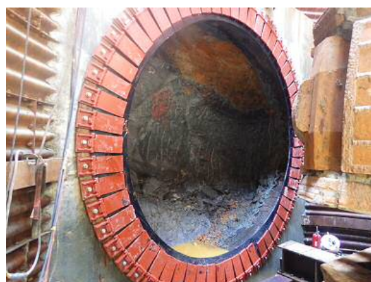
図-4 中間立坑地山
