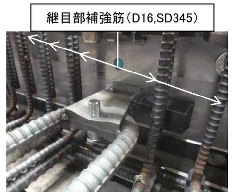
写真5 継手面近傍の配筋状況
