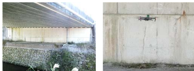
図-2 撮影対象の橋台と UAV による撮影状況
