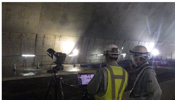
図3 トンネル覆工部撮影状況
