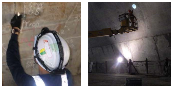
図 2 近接目視点検状況（高所作業車使用）
