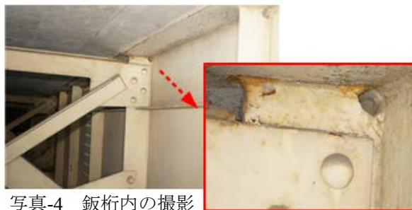
写真-4 鈹桁内の撮影
