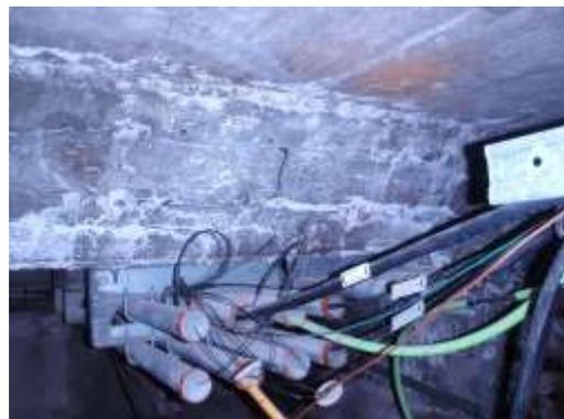
写真1 妙高大橋 PC 箱桁内部劣化と各種センサー計器等やファイバー状センサーによるモニタリング状況
