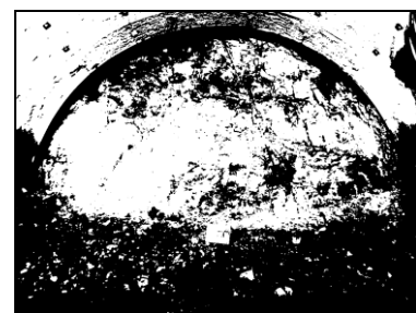
図3 画像処理後のトンネル切羽画像
