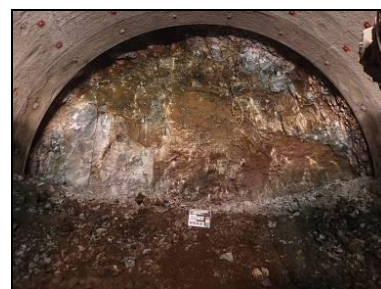
図2 画像処理前のトンネル切羽画像
