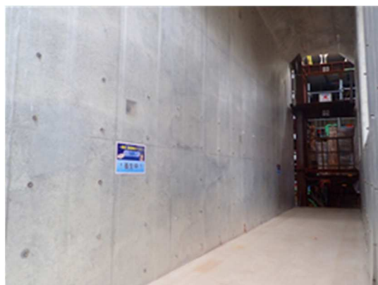
写真－2 養生シート設置完了
