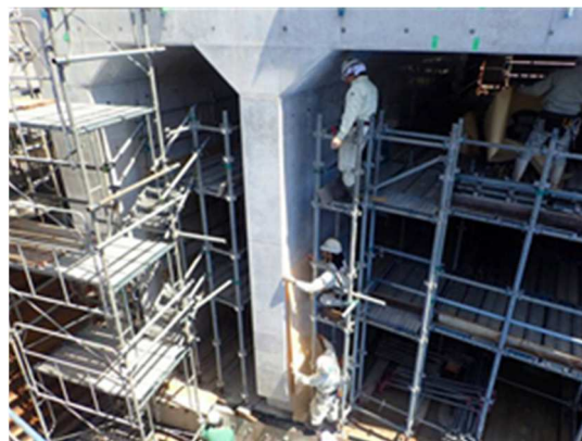
写真－1 貼付型養生シートの設置状況
