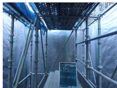
写真5 ポリエチレンによる 封緘養生
