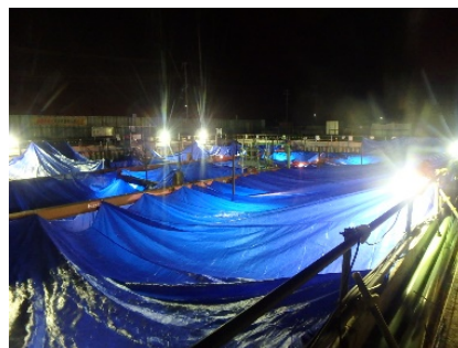
写真2 ブルーシートによる 保温養生
