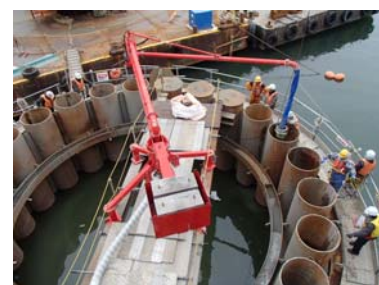
写真-1 打設状況
