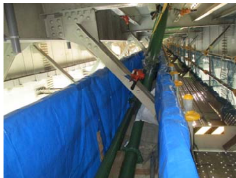
写真-2 点検歩廊内配管状況
