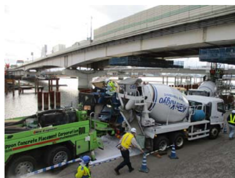
写真-1 圧送試験状況（全景）
