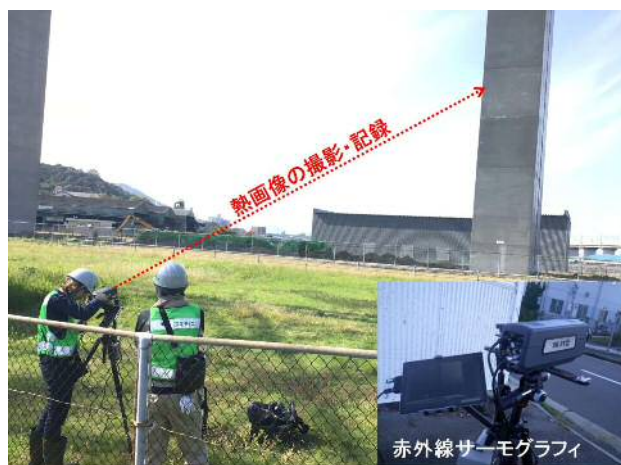
図-2 赤外線サーモグラフィによる浮き調査
