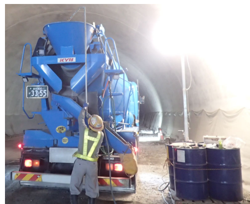
写真-2 流動化剤投入状況
