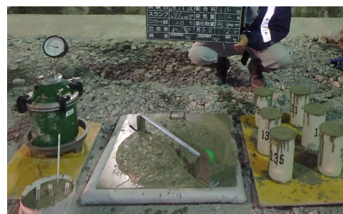
写真-3 流動化剤添加後 受入検査実施状況
