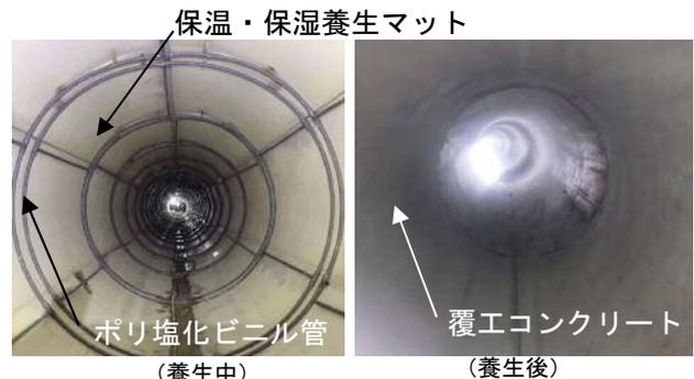
写真-1 シールドトンネル坑内と養生状況
