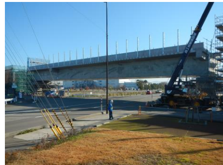
写真-6 施工後全景
