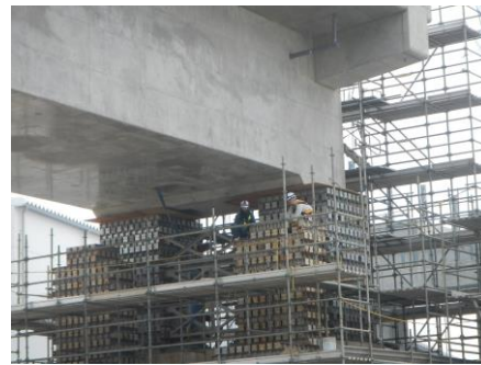
写真-3 サンドル組立状況
