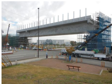
写真-1 施工前全景
