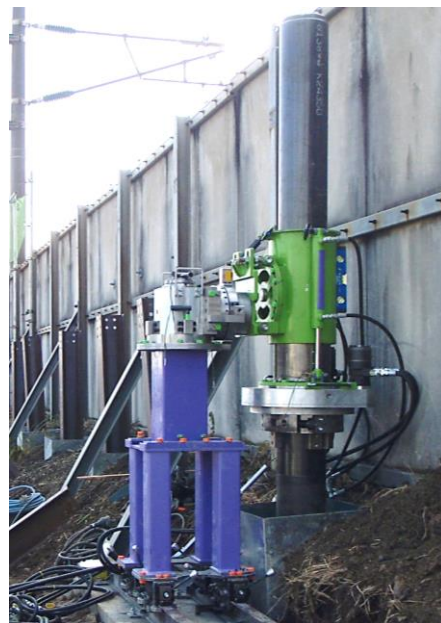
図－1 ポータブル回転圧入機による 盛土部法肩付近での杭打ち
