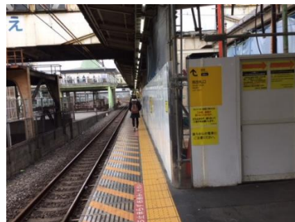
図-1 ホーム上の仮囲いの一例
