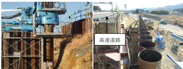
写真－1 鋼管壁体施工状況
