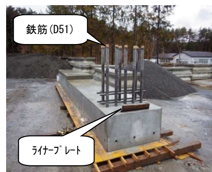
写真-2 充填確認（試験施工）
