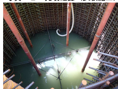
写真-3 トレミー管配置状況
