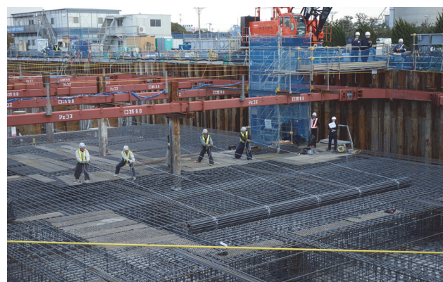
写真-7 下水処理場の底版の上筋での引張展開式工法の施工状況
