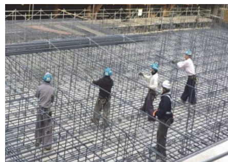
写真-3 引張展開式工法による展開状況
