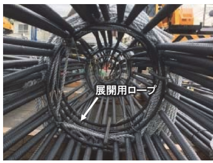
写真-2 引張展開式工法で用いる展開用ロープ
