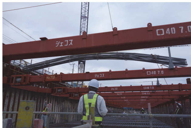
写真-6 コラム切梁による施工環境とロール状先組み鉄筋の投入状況
