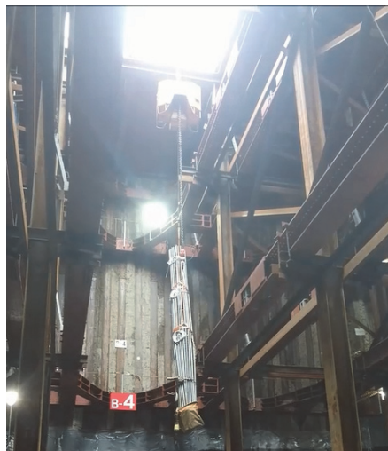
写真-4 開口部から縦吊りでの投入状況
